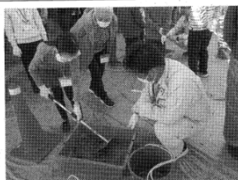
砂やセメント、採石などを混ぜてコンクリート作りを体験した
